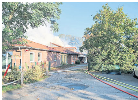
Ein Großfeuer im Buchholzer Kindergarten sorgte für einen Großinsatz der Feuerwehren. Foto: mü
